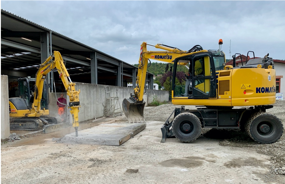
Bild 1: Im Bildungszentrum Bau in Geradstetten steht im 2. Ausbildungsjahr Praxis an: Anhand der neuen Komatsu-Maschinen lernen die Auszubildenden neueste Maschinentechologie kennen.
