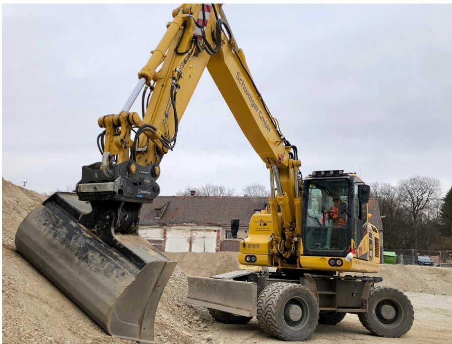
Bild 3: Die beiden Mobilbagger sind gerade für beengte Platzverhältnisse optimal.
