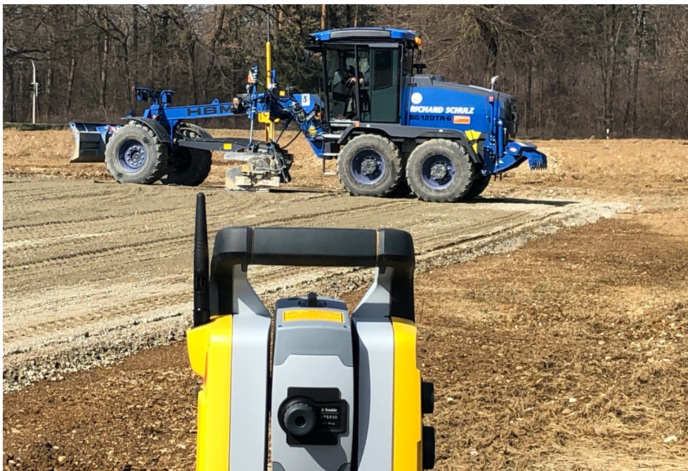
Bild 1: Der HBM-NOBAS Grader BG 120TA-6 wurde mit einer 3D – Tachymetersteuerung, einem 3-Wege-Kamerasystem und einem hydraulischem Scharseitenblech direkt zur aktuellen Baustelle von Schulz gebracht.
