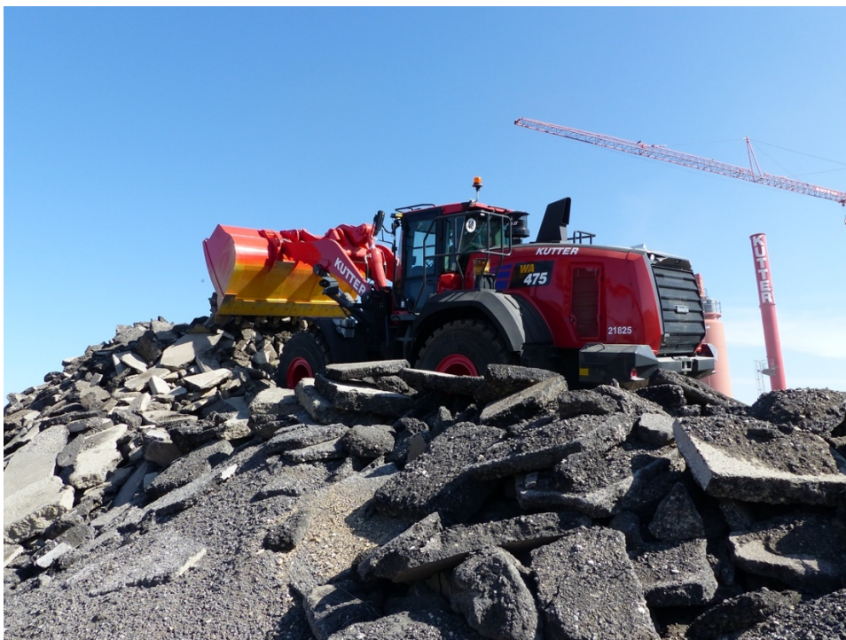
Bild 1: Asphalt Fräsgut auf Halde zu schieben ist eine der Aufgaben, die der neue Komatsu WA475-10 bei Kutter im firmeneigenen Asphaltwerk bei Woringen übernimmt.
