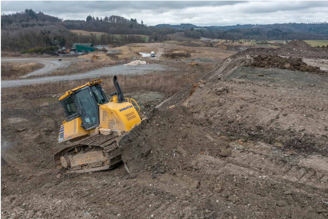
Bild 2: Die D61PX-24 wird für Planierarbeiten in der Erddeponie gebraucht, für Rekultivierung und Wegebau und Instandsetzung auf dem Gelände.
