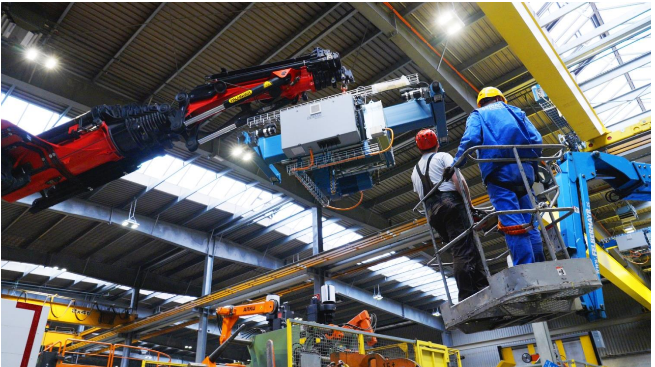
Der PALFINGER PK 165.002 TEC 7 glänzt bei der Montage des neuen Hallenkran.
