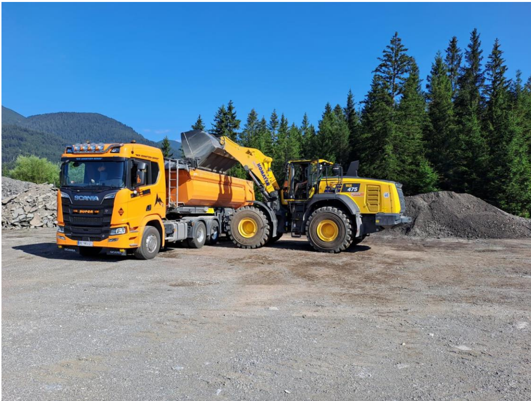
Eingesetzt wird der neue Radlader in Ehrwald sowohl im Kieswerk, als auch in der Deponie, der Schottergrube und dem Steinbruch
