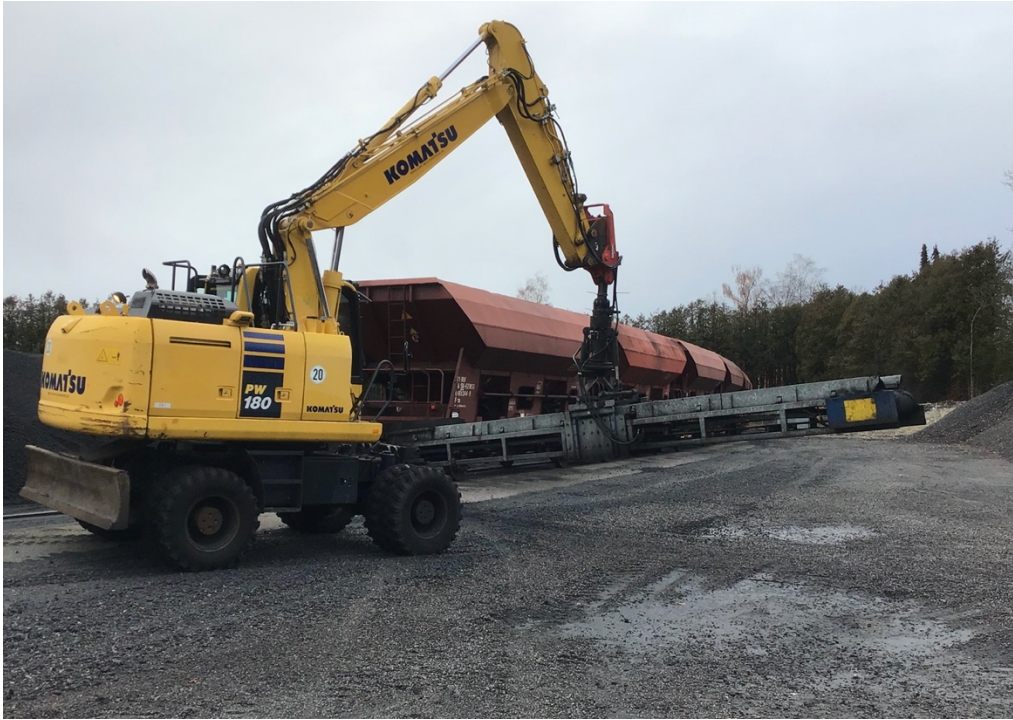
Bild 2: Mit dem Mobilbagger PW180 und dem Förderband wird der Schwarzstoff vom Güterwagen entladen und in das Freilager transportiert.
